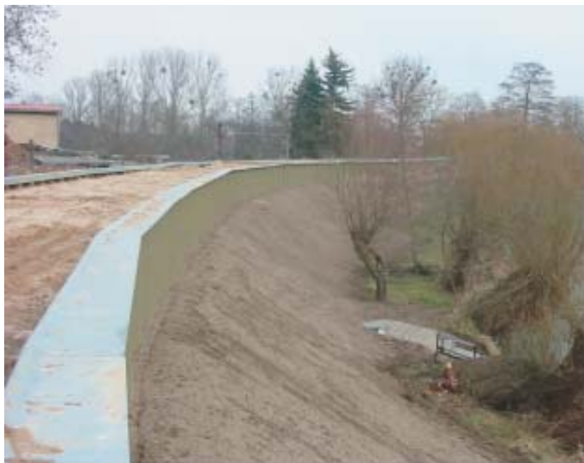
Deichverstärkung mit beidseitiger Spundwand am Scholitzer See
