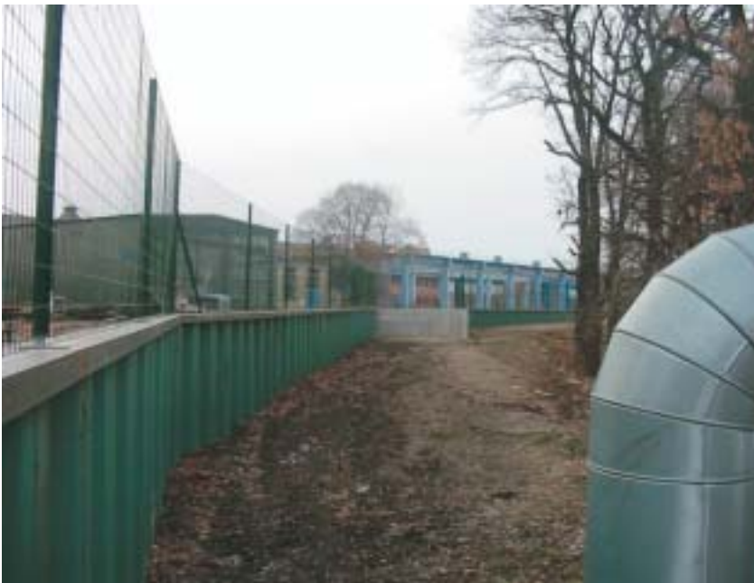
Spundwand als Grundstücksgrenze zum Industriepark Waggonbau
