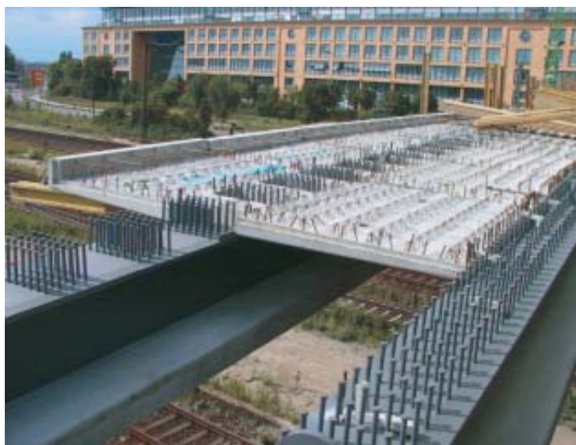
Fertigteilplatten auf Preflexaußenträger
