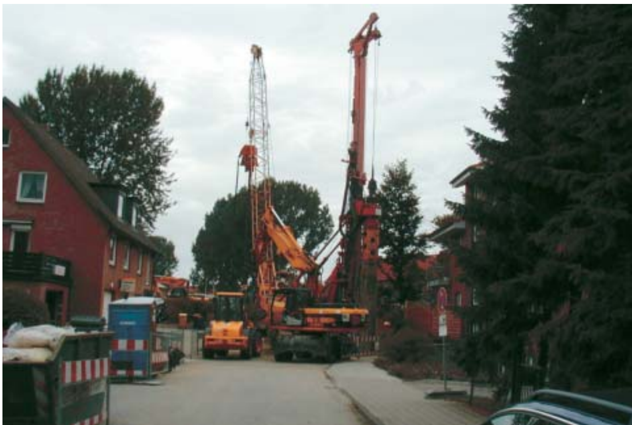
Einbringen von Spundwänden
