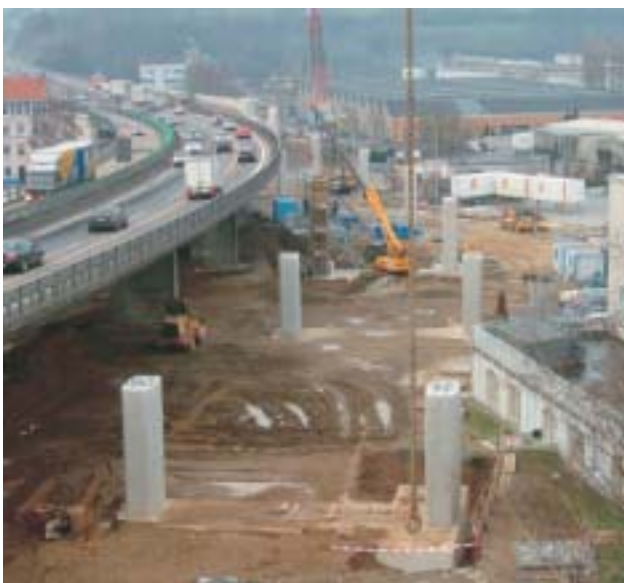
Fertige Pfeilerreihe für den Überbau Ost
