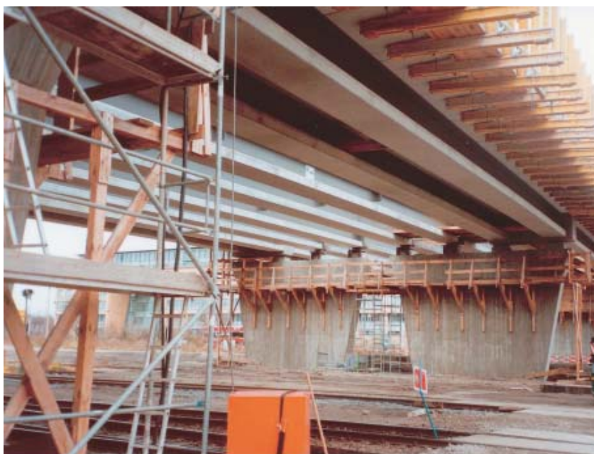
Preflex auf neuen Unterbauten
