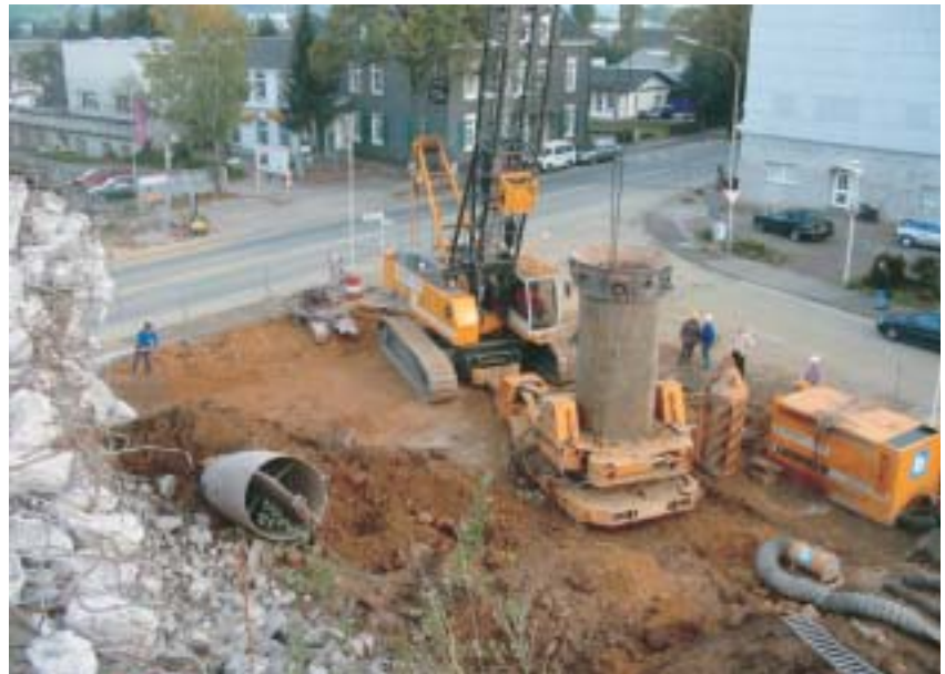
Bohrpfahlarbeiten Ø 180 cm Widerlager Achse O-Ost
