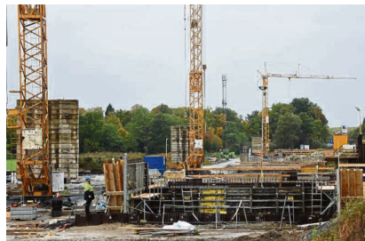
Fast fertig: Die Unterbauten für die Lippe-Brücke (Foto) und die Lippeumflut-Brücke. Bei Letzterer geht’s etwas schneller: Schon in 14 Tagen rückt der Schwertransport an, der die Bauteile für die Lippeumflut-Brücke bringt. Bei der Lippe-Brücke geht’s im Januar ans Eingemachte: Das längste Fertigteil ist 35 Meter lang. Allein für die Unterbauten wurden unzählige Tonnen Stahl verarbeitet.
