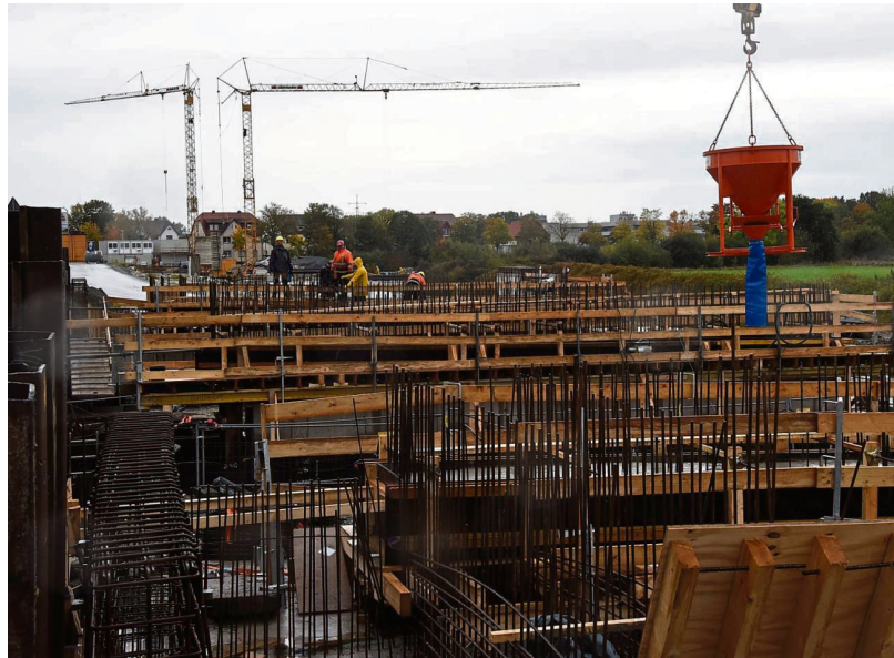
Betonieren für die B 55-Brücken: Derzeit wird an den Unterbauten der neuen Brücken gearbeitet, die Bewehrung einbetoniert. FOTOS: TUSCHEN
