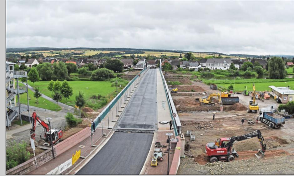
Die Brücke ist fertig, es wird asphaltiert, Baugerüste sind abgebaut und Bagger stellen die Flächen wieder her. Foto: Harald Iding
