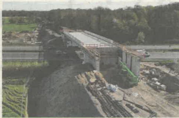
Geschwindigkeitsschub: Mit der Expressbrücken-Bauweise lassen sich Autobahnbrücken wesentlich schneller bauen als mit herkömmlichen Methoden. Foto: Jörn Schumacher
