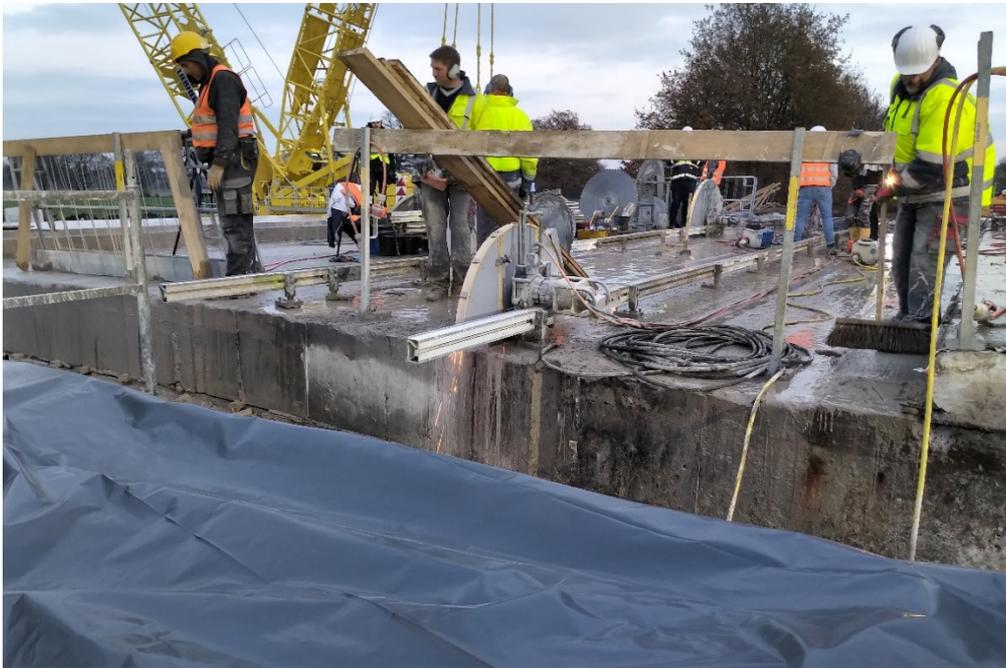
**Bild 10: Ausheben der Überbauelemente**
