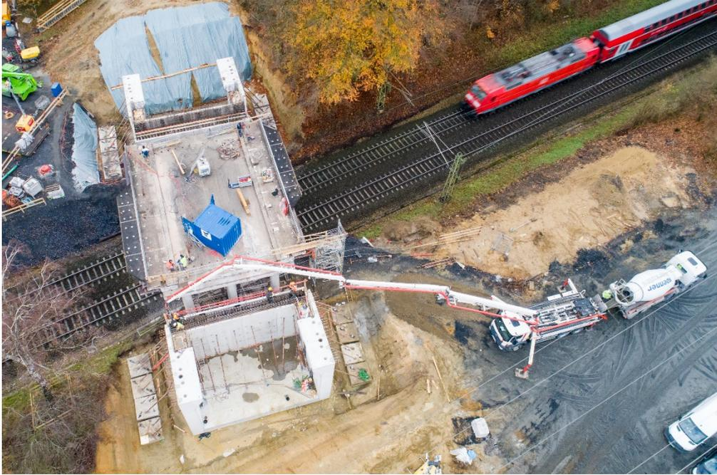
Zu Beginn der **Bauphase 4** (Sperrpause der Bahnstrecke vom 25.-27. November) wurde die Bruckenplatte mit insgesamt 10 Langsschnitten zerteilt und die mit Stahltragern stabilisierten einzelnen Teilelemente herausgehoben (Bilder 9 und 10). Nach Entfernung der Stahlhilfskonstruktion wurden die 6 Pfeiler abgetrennt und samt Quertrager ausgehoben (Bild 11).
