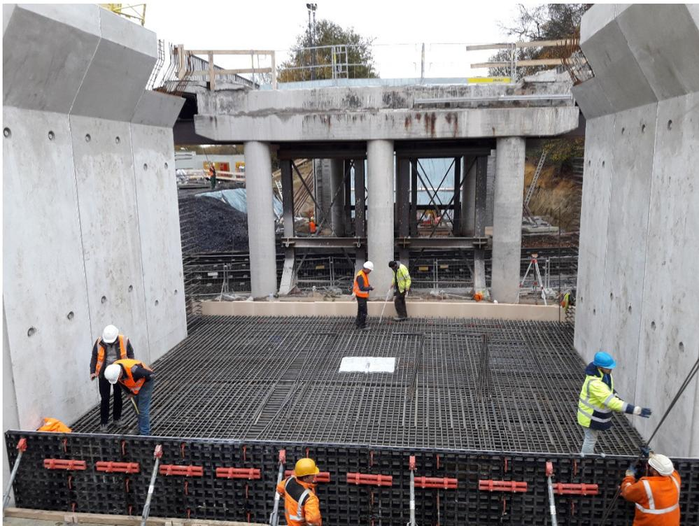
**Bild 8: Ortbetoneingangung Widerlager**
