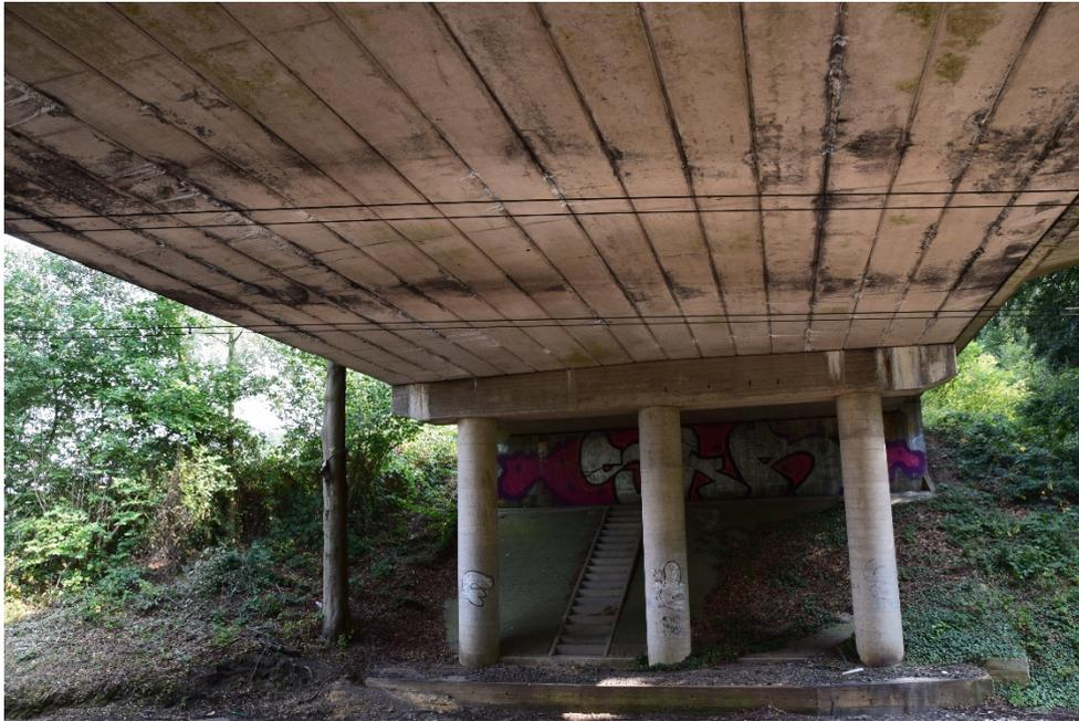
Im Rahmen der regelmäßigen Bauwerksprüfungen wurden an der Überbauunterseite durchfeuchtete Stellen und Aussinterungen festgestellt. Nach umfangreichen Prüfungen ergab sich eine aktuelle Zustandsnote des Bauwerks von 3,4 (Bild 2). Da auf Grund der Durchfeuchtungen mittelfristig gravierende Schäden an der Quervorspannung zu erwarten waren und die vorhandene Brückenklasse 60 für die heutige Verkehrsbelastung der B 474 nicht mehr angemessen ist, war ein zeitnaher Ersatzneubau erforderlich.
