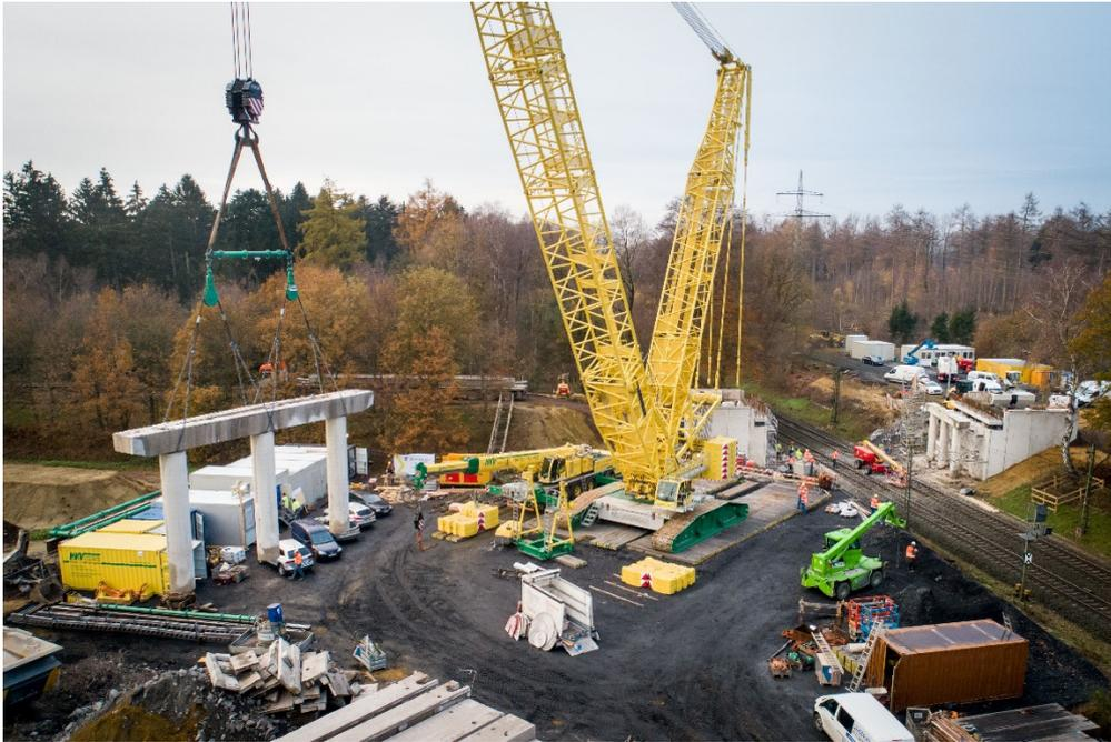
Unmittelbar nach Abschluss der Abbrucharbeiten wurden in der **Bauphase 5** (Sperrpause der Bahnstrecke) die Fertigteilträger für die neue Brückenplatte eingehoben. Neben den bewährten Halbfertigteilträgern im Fahrbahnbereich wurden die Randfertigteilträger unter Verwendung selbsttragender Hybridkappen mit bereits vormontierten Geländern und Berührungsschutzelementen eingebaut (Bilder 12 und 13).
