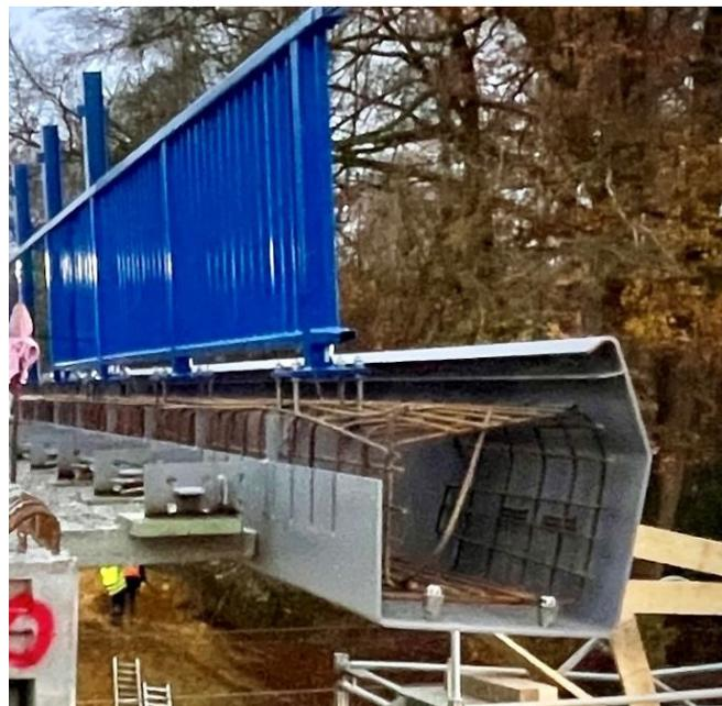
Eine als Falwerk geformte und ausgesteifte verlorene selbsttragende Stahlschalung, die verzinkt und außen mit einer Duplex-Korrosionsschutzbeschichtung versehen ist, bildet die seitliche Umgrenzung von Kappe und Gesimsbalken. Eine separate Kappenschalung war so nicht erforderlich. Die am Bauwerk verbleibende Hybridkappenstahlschalung übernimmt nur für den Bauzustand eine tragende Funktion. Die
