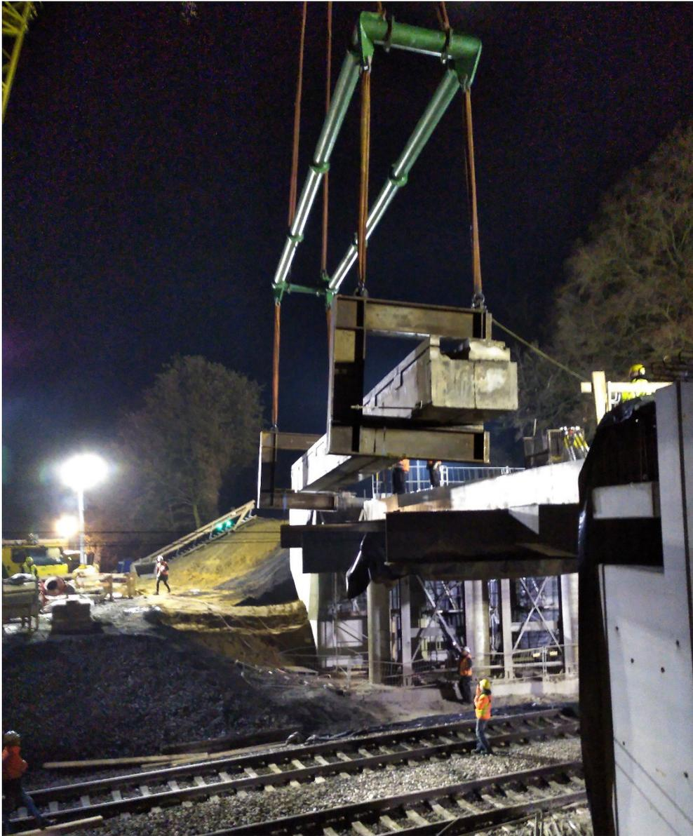
**Bild 11: Ausheben der Pfeiler und Querträger**
