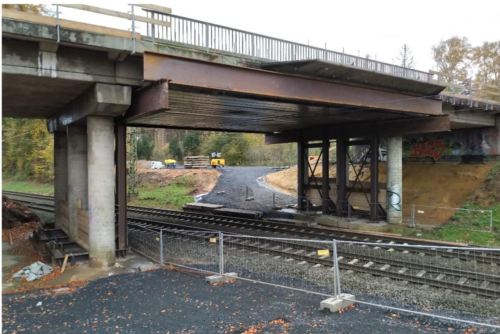
Mit Beginn der **Bauphase 2** Anfang November wurde die B 474 für 40 Tage voll gesperrt. Die Endfelder der Brücke wurden geschnitten und abschnittsweise ausgehoben. Anschließend wurden die alten Widerlager abgebrochen.
