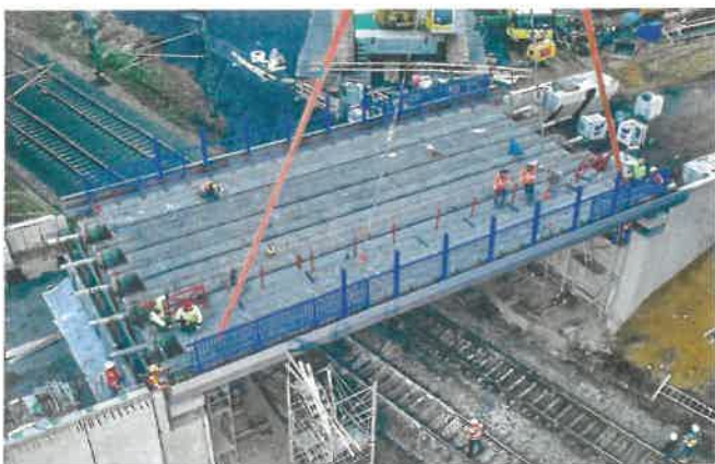
Bild 2 B474 OU Dülmen–Auflegen der Spannbetonüberbaufertigteile mit aufgesetzter Hybridkappe sowie Geländer- und Berührungselementen; Gesamtbauzeit: 40 Kalendertage
