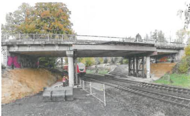
Bild 6 B474 OU Dülmen – alte Bestandsbrücke, Stahlkonstruktion zur Stabilisierung des mittleren Brückenfeldes
