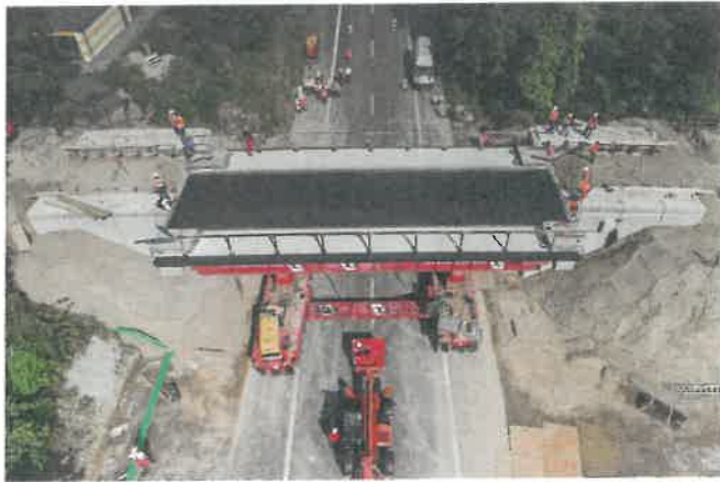
Bild 5 B68 Schulstraße, Georgsmarienhütte – Einschub fertiggestelltes Brückenbauwerk
