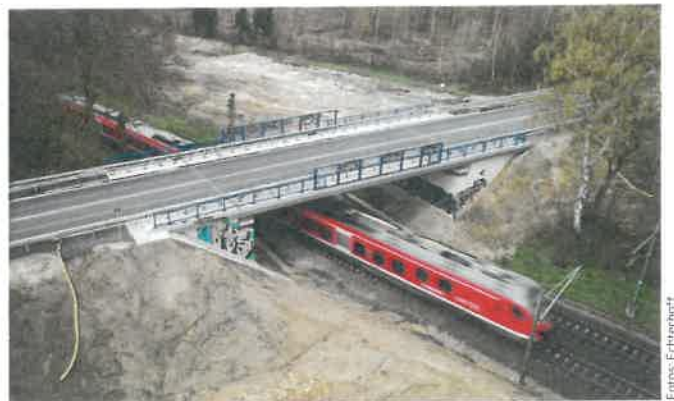
Bild 8 B474 OU Dülmen – Fertiges Brückenbauwerk nach 40 Kalendertagen
