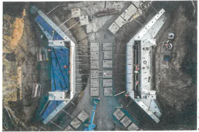
Bild 10 Vellinghauser Straße, Dortmund – 6. und 7. Tag: Betonage Widerlager
