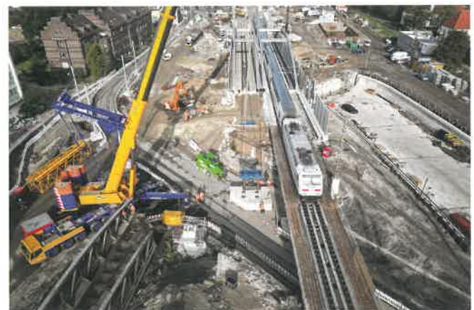
Bild 3 Nicht nur die Herstellung der Behelfsbrücke (im Bild) musste „unter rollendem Rad“ erfolgen.
