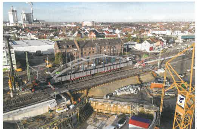
Bild 2 Auf Schwerlasttransportwagen werden die neuen Brücken eingefahren.
