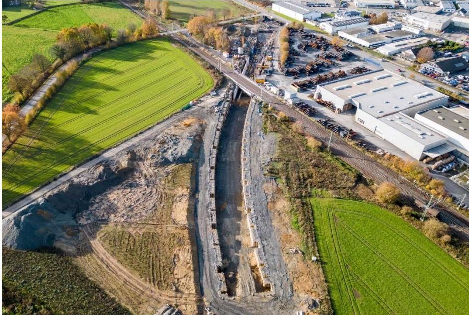
Bild: Bauvorhaben K40n, Kamen; Neubau Bahnunterführung statt Stau vor Schrankenanlage; ein Beitrag zum Umwelt- und Naturschutz
