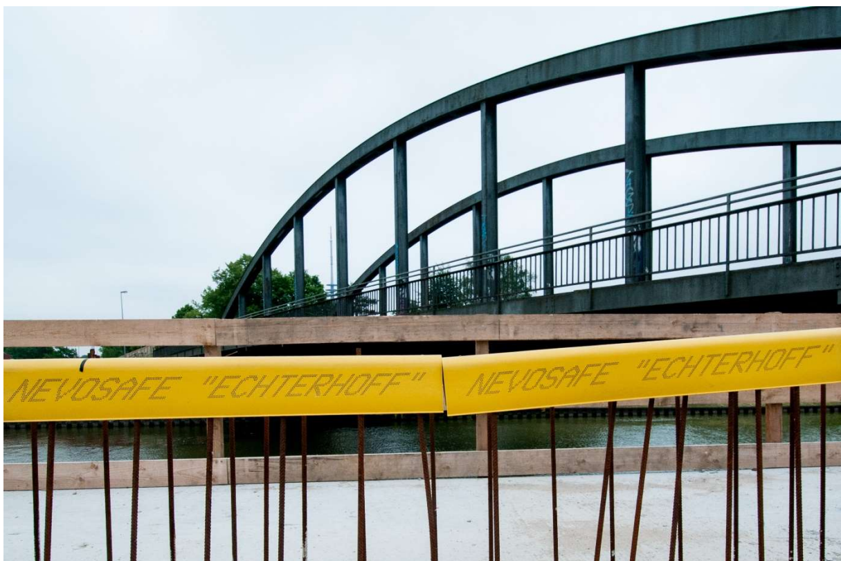
Bild: Sicheres Arbeiten durch Abdeckung aufgehender Bewehrungsstähe
