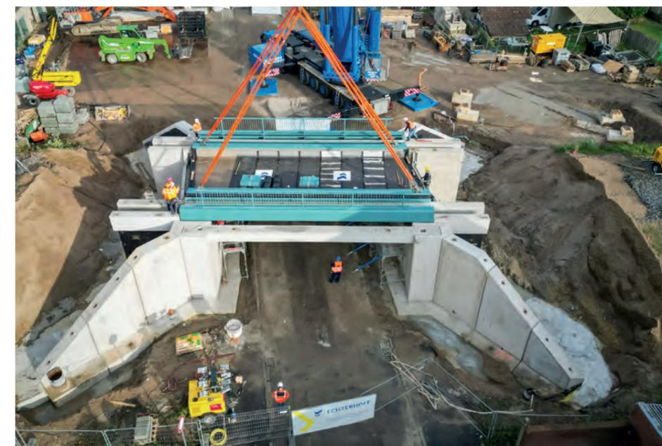
Bild 4: Osnabrück, Eisenbahnüberführung – Brückenbau in nur 6 Tagen dank der modularen ECHTERHOFF Expressbrückenbauweise.
