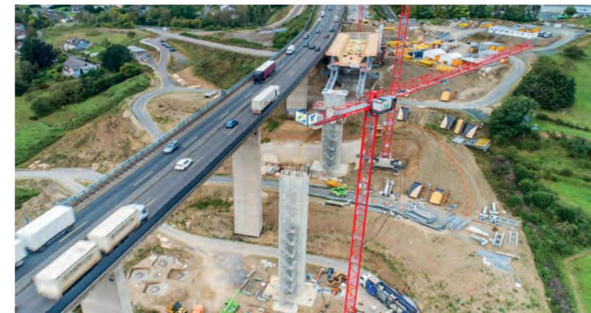
Bild 2: Talbrücke Eisern, A45 – Ersatzneubau mit Hilfe einer Vorschubrüstung.
