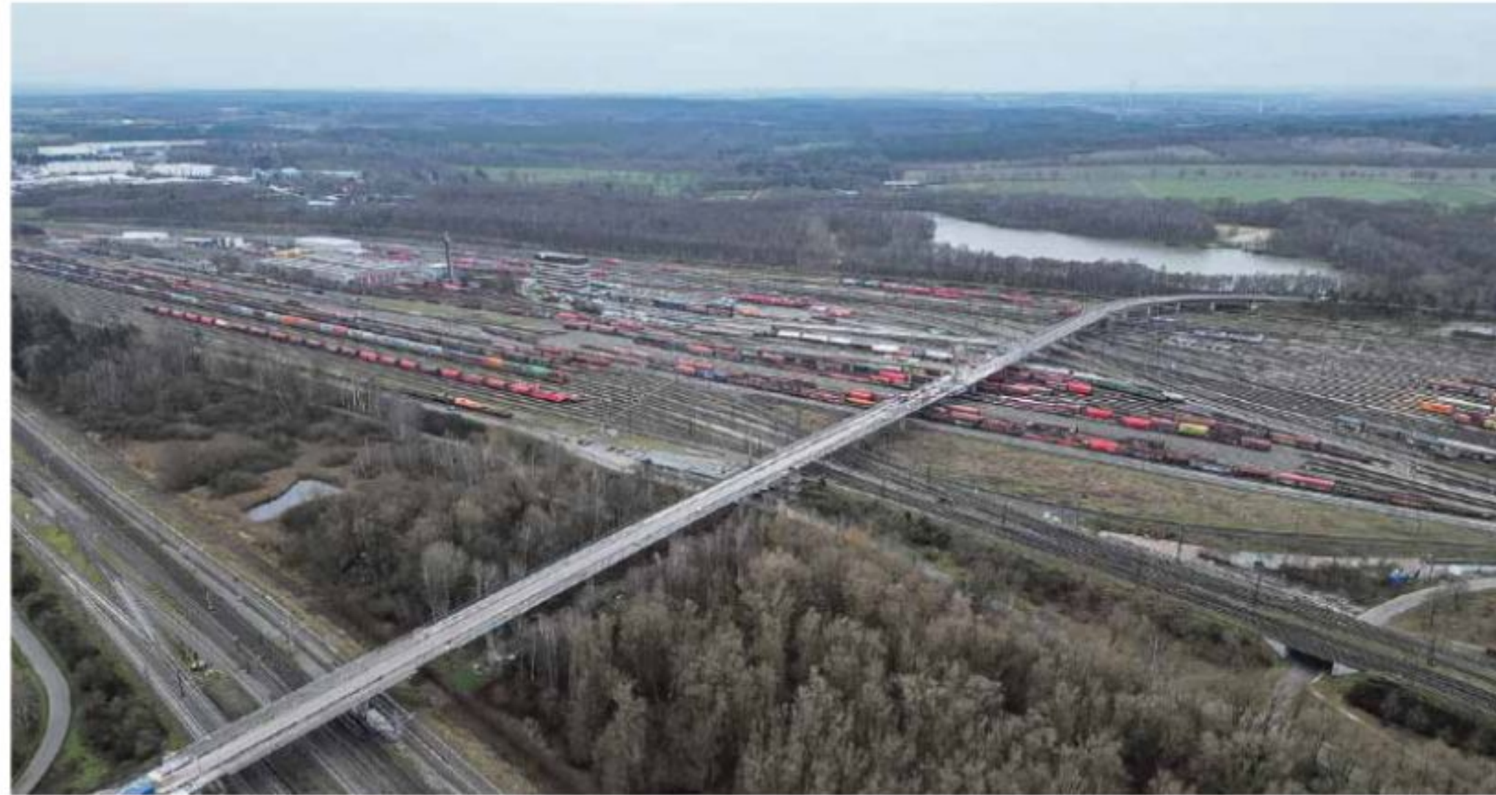
Herausforderndes Sanierungsprojekt: Die 750 Meter lange Decatur-Brücke in Seevetal (Niedersachsen) soll im Jahr 2026 wieder für den Verkehr freigegeben werden. Foto: Echterhoff
