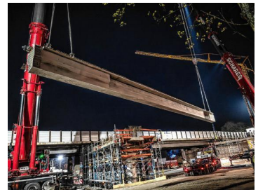
Schwere Lasten, mit viel Fingerspitzengefühl bewegt: Bis zu 121 Tonnen wiegen die passgenau vorproduzierten Beton-Fertigteile für die neue A516-Brücke in Sterkrade.
