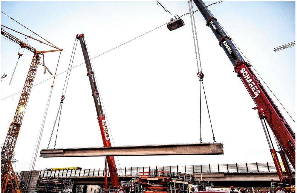
Schwere Lasten, mit viel Fingerspitzengefühl bewegt: Bis zu 121 Tonnen wiegen die passgenau vorproduzierten Beton-Fertigteile für die neue A516-Brücke in Sterkrade.
